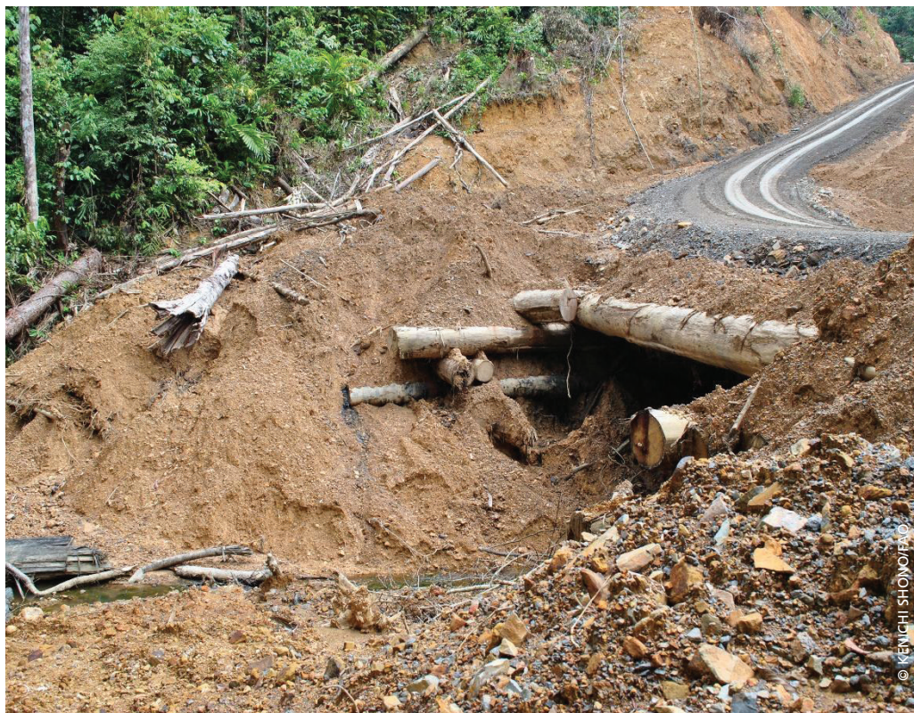
Una carretera forestal con un cruce de arroyo mal construido
